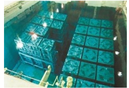
新型転換炉ふげんの使用済み核燃料が保管されているプール=茨城県東海村の東海再処理施設で
