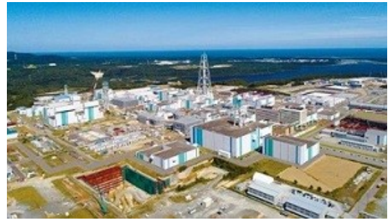
建設が進む使用済み核燃料再処理工場の全景(青森県六ヶ所村)
