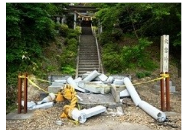
火宮神社の崩れた鳥居=2022年6月20日、石川県珠洲市正院町飯塚
