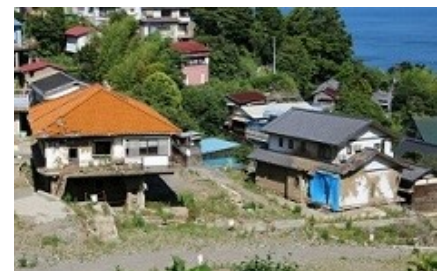
静岡県熱海市で発生した大規模な土石流災害により被災した家屋=6月29日、同市伊豆山(時事通信による)
