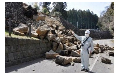
16日の地震で崩壊した仙台城跡の石垣=30日午前、仙台市青葉区
