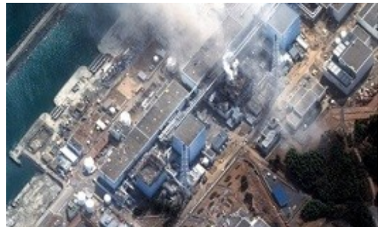
水素爆発を起こし、白煙状の湯気を噴き上げている東京電力・福島第一原子力発電所3号機(中央)。爆発から3分後の14日午前11時4分に撮影された。建物の骨組みがむき出しになっている。左隣が2号機、右隣が4号機。左端の1号機も屋根が吹き飛んだ様子が確認できる=米デジタルグループ提供
