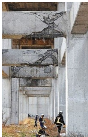
左から順に、 地震で脱線した東北新幹線の車両=17日、宮城県白石市で(東京新聞社へ「おおづる」から) 地震の激しい揺れであちこちが崩落した東北新幹線の橋脚=17日午前10時20分ごろ 地震で傾いた仙台城跡の伊達政宗騎馬像=17日午前8時ごろ、仙台市青葉区川内 地震で崩れ落ちた仙台城跡の石垣=17日午前7時35分ごろ、仙台市青葉区川内
