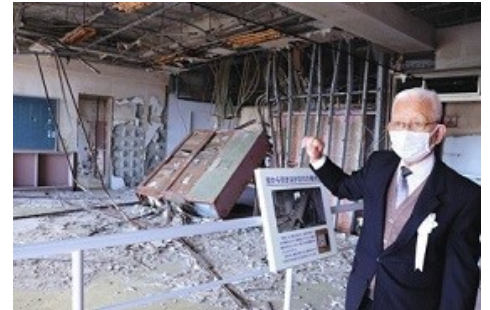
震災遺構に認定された請戸小学校の1階職員室。津波で壁から引きはがされた複合壁の前で鈴木市夫さんが当時を振り返った＝福島県浪江町で
