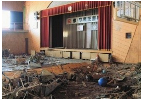
震災2カ月後の請戸小学校体育館。震災当時、卒業式の準備が行われていた。床は大きく段差ができ、津波で泥だらけになっている=2011年5月、福島県浪江町で(陸上自衛隊提供)
