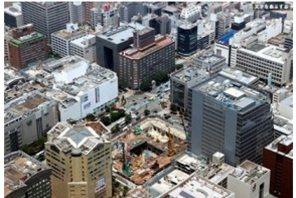
再開発の工事が進む天神交差点(中央)周辺=6月,福岡市中央区,朝日新聞社へりから
