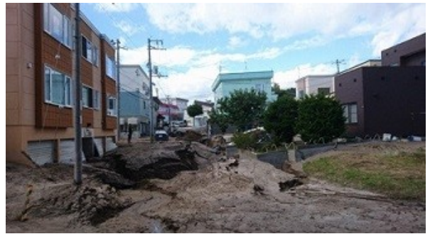
地震当日の住宅街。大量に流出した土砂が道路を覆い、奥の住宅は大きく傾いていた＝札幌市清田区里塚地区で2018年9月6日
