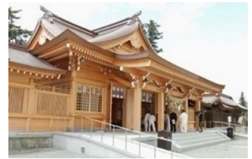
再建工事が完了した阿蘇神社の拝殿=12日午後、熊本県阿蘇市
