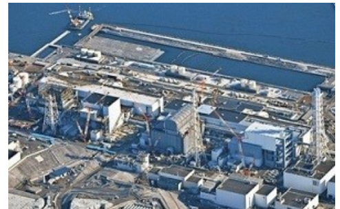
事故収束作業が続く東京電力福島第一原発=福島県大熊町で、東京新聞本社へ「おおづる」から
