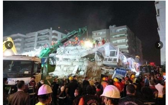
トルコ西部のイズミルで救助作業が続く建物の倒壊現場。深夜になっても重機を使った救助が行われていた=2020年10月31日午前1時29分、イズミル。朝日新聞現地特派員撮影
