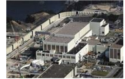
宮城県の東北電力女川原発2号機=8月(共同通信社へりから)
