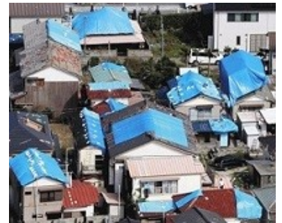
屋根にブルーシートが掛けられた建物が目立つ住宅街=2019年9月15日(東京新聞より)
