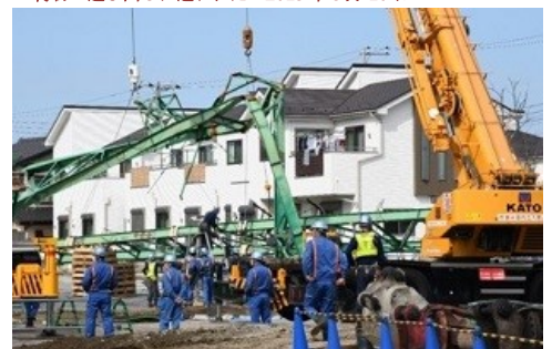
台風から2ヵ月近くたって鉄柱撤去を開始。11月中旬に全ての自宅から取り除かれた=2019年10月28日
