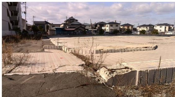
陸前高砂駅近くの高層マンションは解体されたまま。路盤は左側に傾いている。
