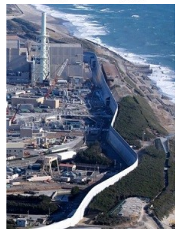
防波壁に囲まれた中部電力浜岡原発(朝日新聞より)。こんな壁だけで東海地震津波から原発を守ることが本当に可能だろうか。
