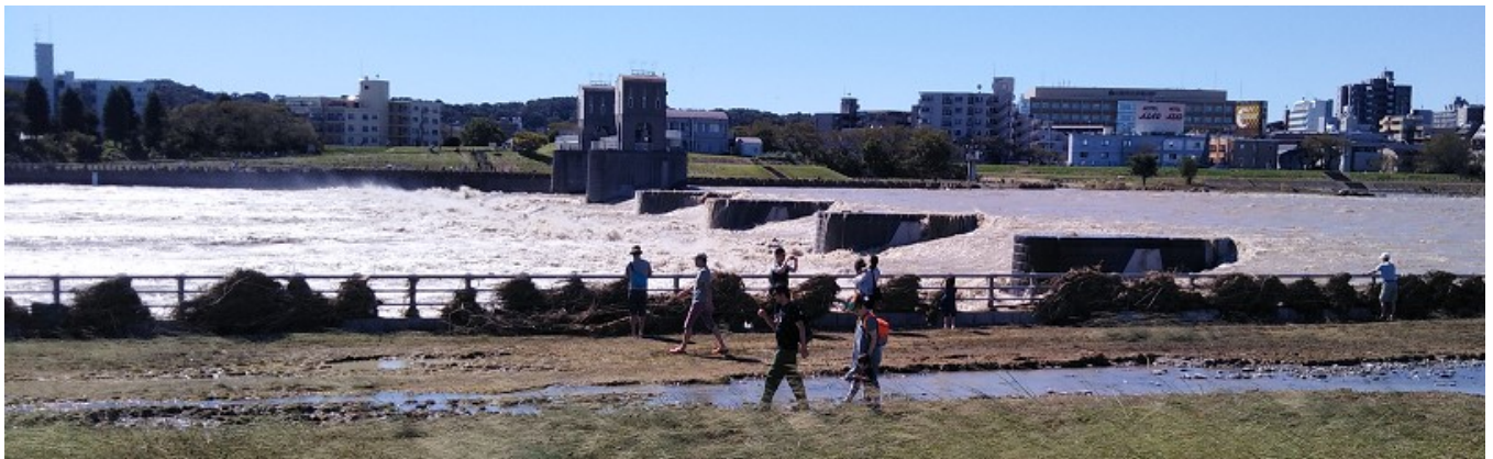
台風 19 号が過ぎ去った翌朝の多摩川。場所は 1974 年の多摩川決壊で注目された東京都狛江市猪方地先。対岸は川崎市宿河原（10 月 13 日，筆者撮影）
