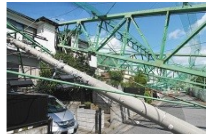
住宅を直撃し、2週間以上撤去されずに放置されているゴルフ練習場の鉄柱=いずれも 23日、千葉県市原市で
