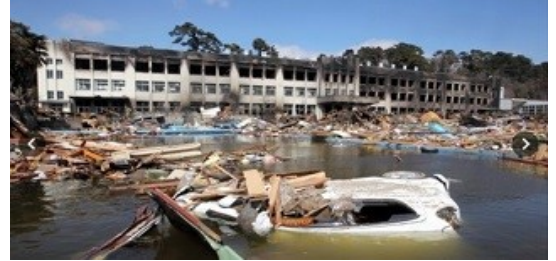
焼けこげた旧門脇小学校の校舎。手前のプールには乗用車が沈んでいた＝2011年3月18日、宮城県石巻市(朝日新聞 10/8より)
