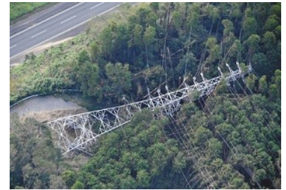
倒壊した送電線の高圧鉄塔=11日千葉県君津市で、東京新聞社へリ「あさづる」から
