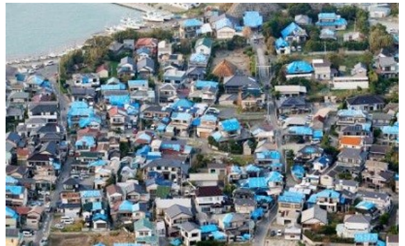
台風15号による被害で屋根が損傷し、ブルーシートが掛けられた多数の住宅=15日午後5時13分、観南町(共同通信社ヘリから)
