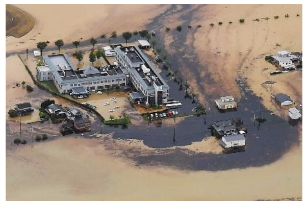
猛烈な雨による冠水で孤立した佐賀県大町町の順天堂病院。鉄工所から流れ出した油の混じった水が院内に入り込んだ=28日(共同通信社へリから)
