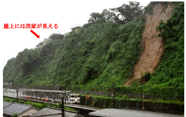
JR 南鹿児島駅のすぐ裏で起きた土砂崩れ。手前左は鹿児島市電のホーム=7月3日午後2時48分、鹿児島市
