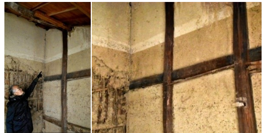
蔵の壁を指さす森脇敏さん。西日本豪雨の水位の到達点(白い線の下端)の上に1893年の水害の水位(白い線の上端)がある=2019年1月28日、岡山県倉敷市真備町岡田にて(朝日新聞デジタルより)
