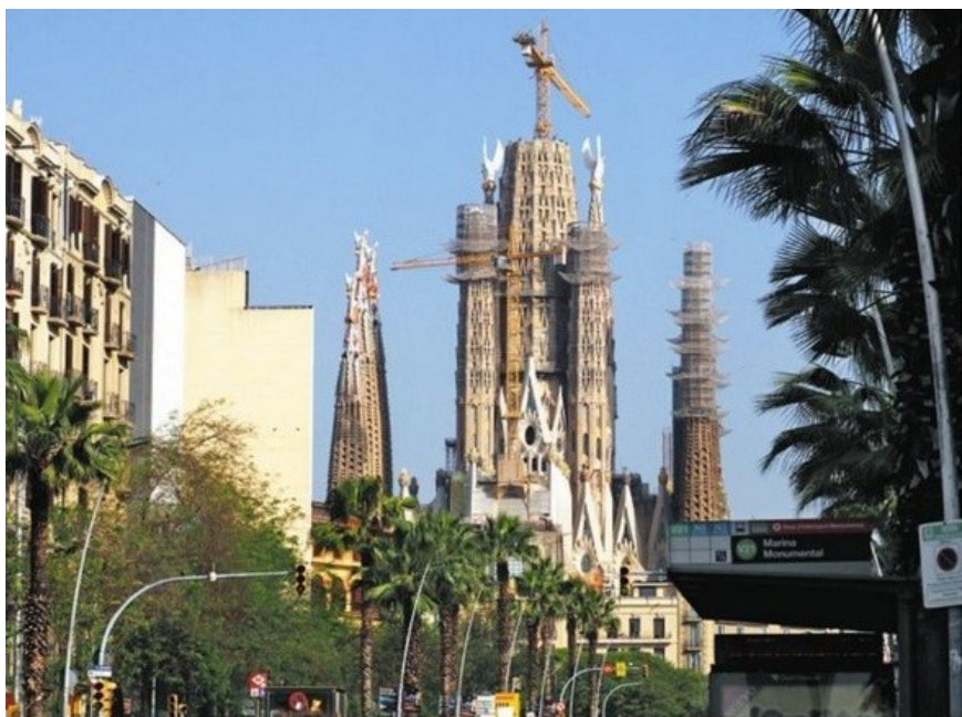
バルセロナ市内で、南側から見たサグラダ・ファミリア。中央の建設中の塔が2026年完成予定のメインタワー「イエスの塔」
