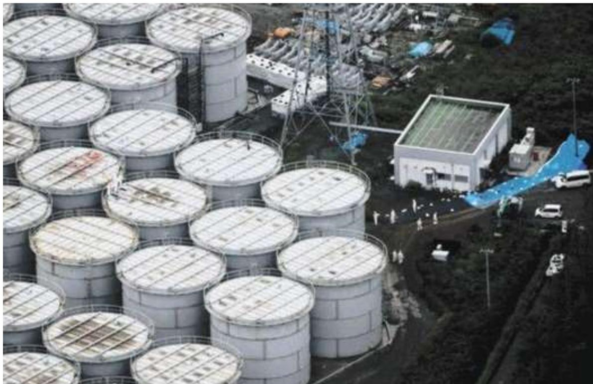
約300トンの汚染水漏れを起こしたボルト締め型のタンク群=2013年
