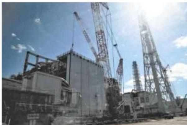
大きく損傷した3号機原子炉建屋の側面に設置された鋼鉄製の囲い＝2012年10月
