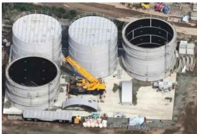
組み立て中のボルト締め型タンク。鋼板パーツをボルトでつなぎ合わせ、
