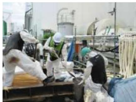
2号機の海側にある地下トンネル上で、たまった汚染水を凍らせるため補助的に氷を投入する作業員＝東京電力提供
