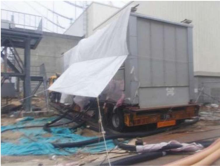
ネズミが感電し、大停電の引き金となった仮設の配電盤＝2013年、東京電力提供
