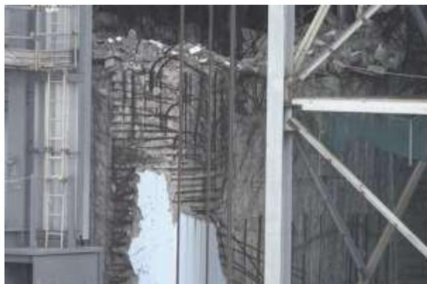
水素爆発のすさまじさを物語る3号機原子炉建屋の崩落部。厚いコンクリート壁が崩れ、鉄筋がむき出しになっていた＝福島県大熊町の東京電力福島第一原発
