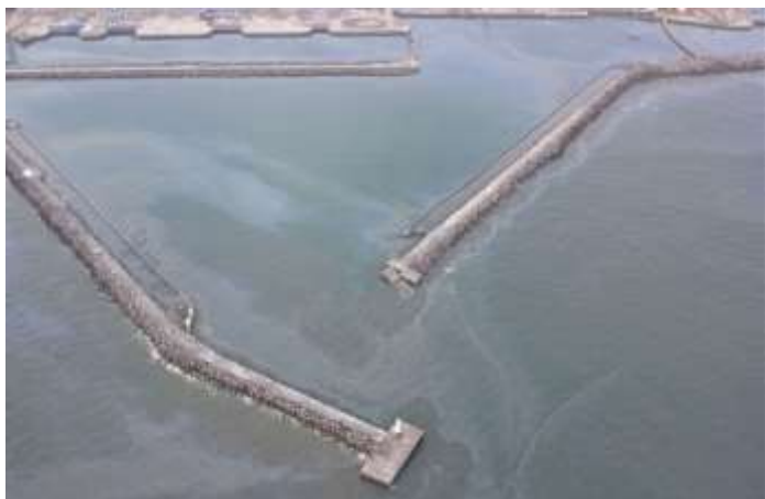
写真 9 福島第一原発 1~4 号機前の防波堤。何の油かは不明だが、油膜が外洋に広がっている。
