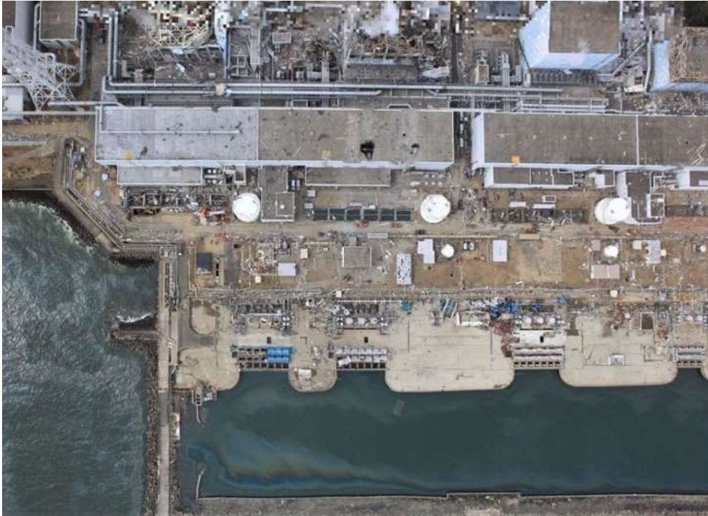
写真1 上部の右から 1、2、3、4 号機。護岸の海水ポンプなどは津波で破壊された。中央付近に四角いの入った槽(逆洗弁ピット)があり、ここに海水をため、そこから消防車で原子炉に注水していた。
