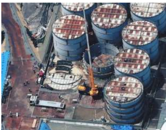
写真5 敷地南端では、水漏れリスクの高いボルト締め型タンクの解体が進められていた。
