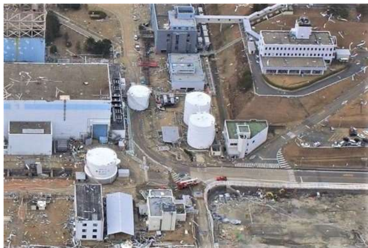
写真 4 海側から見た 1 号機(左)。護岸近くにあった重油タンクが道路をふさいでいる。
