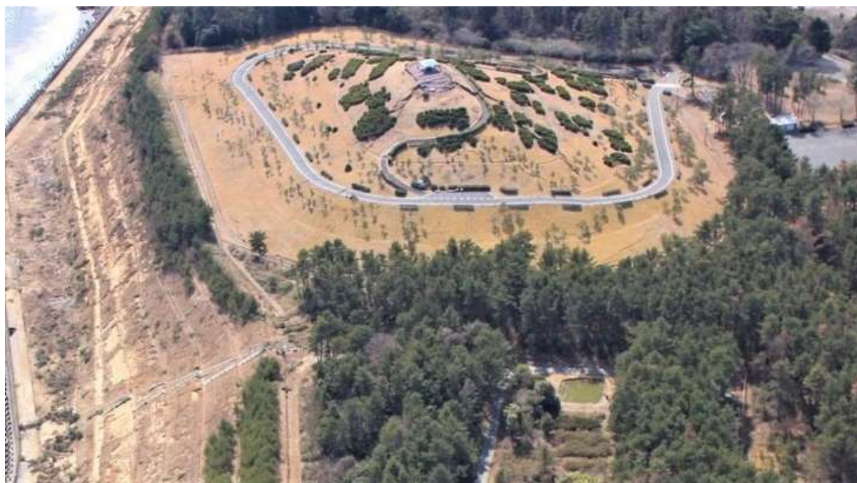
写真 13 福島第一原発の南側にあった展望台。現在は伐採した樹木の枝葉を保管する施設となっている。
