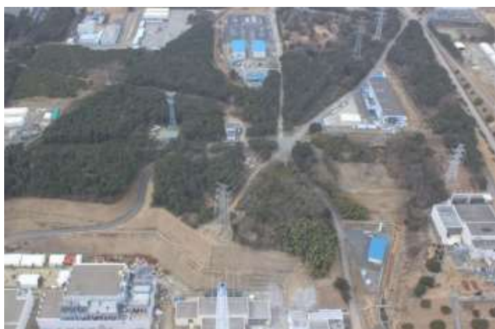
写真 11 1~4 号機の山側。当時は松林が広がっていたが、その後、全て伐採され、汚染水処理後の水をためるタンク用地へと変わった。
