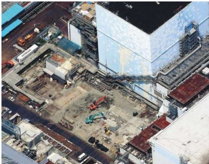
写真3 2号機の使用済み核燃料は建屋側面に穴を開けて取り出す。装置を載せる構台用地の準備が進められていた。
