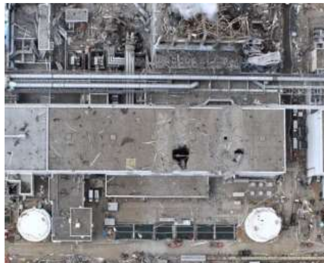
写真 6 3 号機のアップ。槽の近くに並んだ注水用の消防車、吹き飛んだ建屋がれきの状況がよく分かる。
