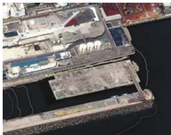
写真7 かつて汚染水タンクの代わりに使われていたメガフロートは、内部にモルタルを詰めて着底。今後は物揚げ場などに使われる予定。
