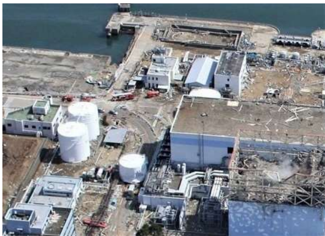
写真 3 山側から見た 1 号機。護岸近くにあった重油タンクが道路をふさいでいる。
