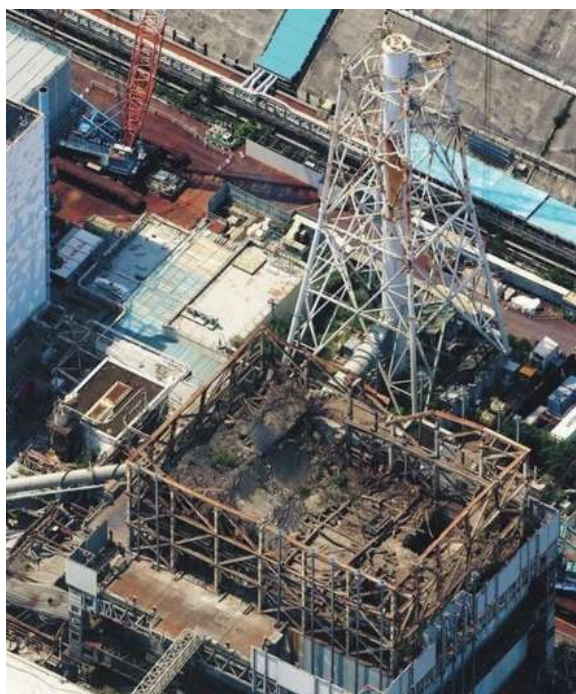
写真2 使用済み核燃料プールの保護作業が進む1号機。その上には大量のがれきが残り、草も生えている。そばに立つ1、2号機排気筒は上半分の解体が終わり、頂部には雨が入り込まないようふた取り付けられた＝福島県大熊町の東京電力福島第一原発で。
