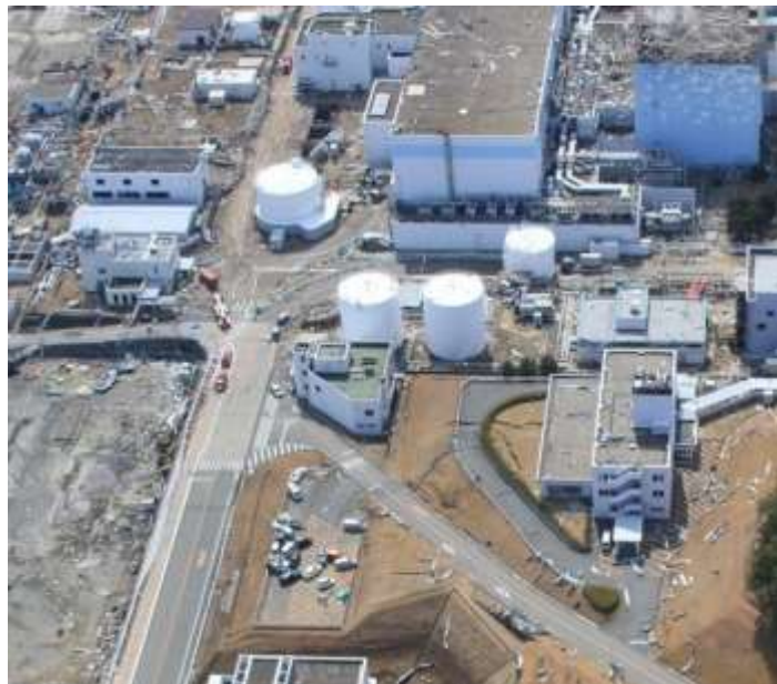
写真 10 1 号機の北側。地震によりりり面や道路に大きな亀裂が入っている。
