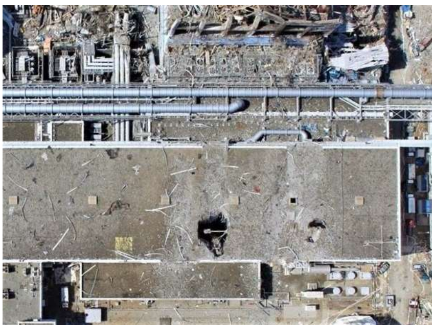
写真 7 3 号機タービン建屋の穴付近を拡大。大きながれきが屋根を突き破っているとみられる。小さいがれきが直線状に降り注いでいる。
