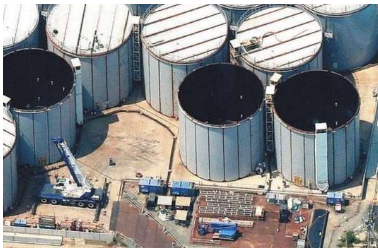
写真6 タンク解体中の隣の区域では、溶接型タンクの新設が並行して進む。汚染水を浄化処理した後の水を保管するタンクは1000基を超えた。
