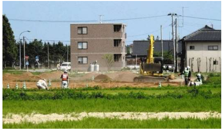
農地除染では、汚染度合いの高い表土を除去し、山砂を入れていく ＝福島県富岡町で
