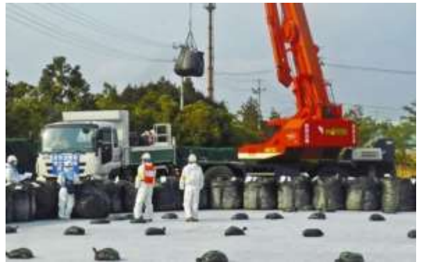
中間貯蔵施設内に運び込まれ、クレーンで保管場に降ろされた汚染土=2015年3月、福島県大熊町で
