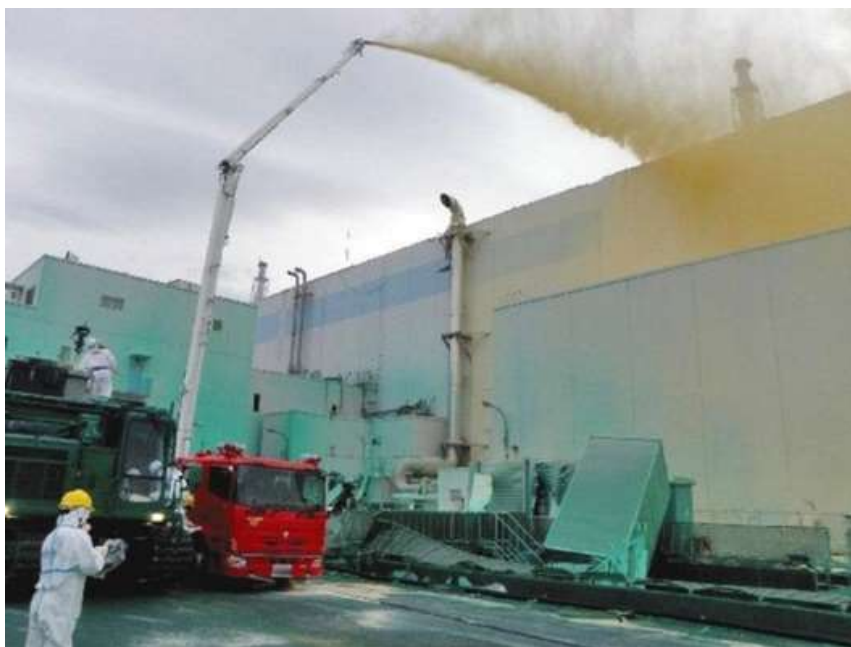
1号機タービン建屋に飛散防止剤を散布する屈折放水塔車(東電提供)
