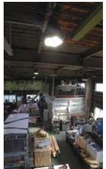
水銀灯に代わり、工場内を照らすLED。省電力だけでなく、作業場に届く光の量も多い
