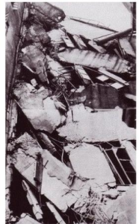
大和百貨店東側面の圧壊箇所。写真左手には南側のコア部分が写っており、右手手前には隣接する酒井ビルがほぼ接している。圧壊した6階位置には倒壊した煙突が写っている。(註)この写真は本文にはなく、他の資料から引用したものである。
