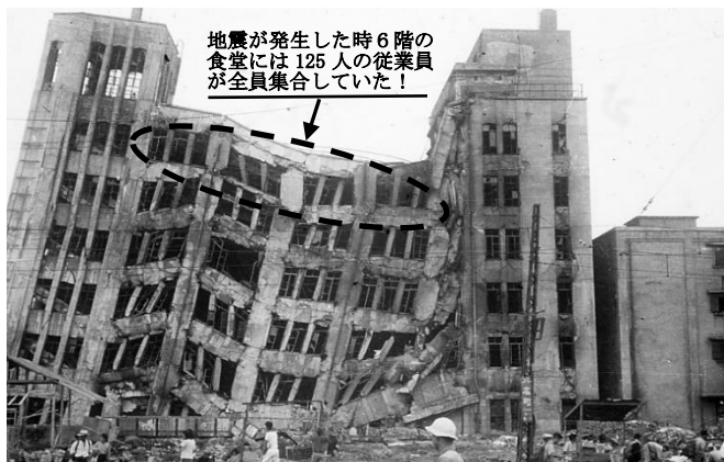
写真1 福井地震で破壊され火災に見舞われた大和百貨店(文献[3]より)
