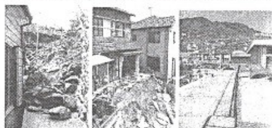
写真3 玄界島の被災状況(主な被害は石垣と屋根瓦)
