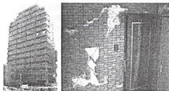
写真6 高層マンションの被害状況(中央区今泉2)
