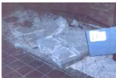
1階に落下した10階部分のコンクリート製手摺り(重さ約500kg)
