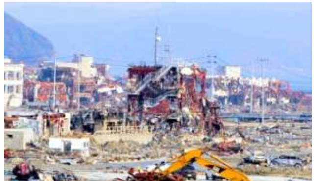
震災直後の南三陸町防災対策庁舎。津波は高さ12メートルの庁舎屋上まで襲った=2011年4月14日午後4時3分、宮城県南三陸町志津川
