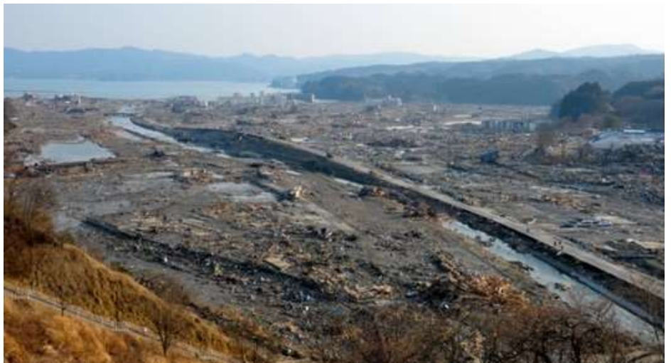
津波で多くの家屋が流された志津川地区=2011年3月13日、宮城県南三陸町
