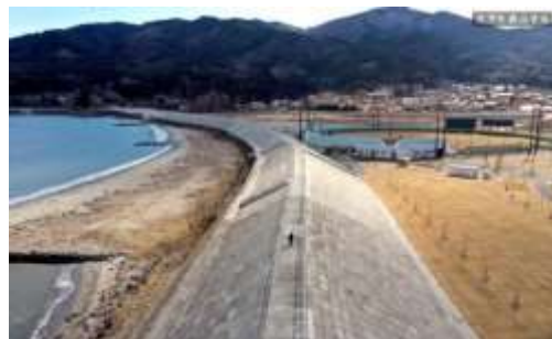
東日本大震災後に整備された高さ10.4メートルの防潮堤。右奥には佐々木さんが暮らす災害公営住宅がある=2021年2月8日、岩手県宮古市
