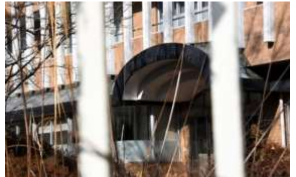
双葉病院の玄関前のアスファルトからは枯れ草が伸びていた=2021年1月31日
