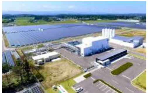
福島水素エネルギー研究フィールド。水素の製造装置がある建屋(中央)の周囲には太陽光発電パネルが敷き詰められている=福島県浪江町、東芝エネルギーシステムズ提供
