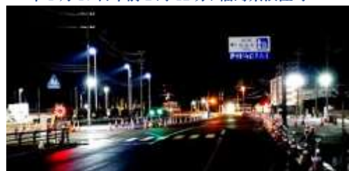
復興工事が続く福島県浪江町中心部。暗闇の中に青と赤の警告灯が光る=2021年1月13日午前2時35分
