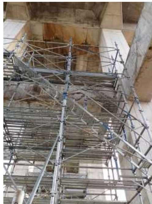
被害は3連ラーメン架構中間部の梁材に連続して発生しており、線路と直交方向に相当揺れたものと考えられる。
