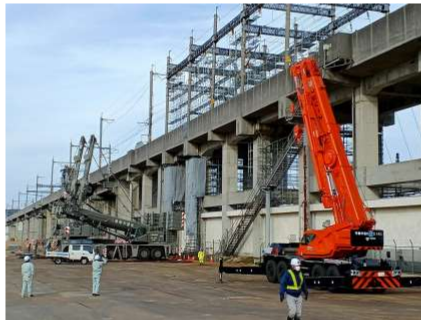
高架橋の補強工事現場には近づかず。
