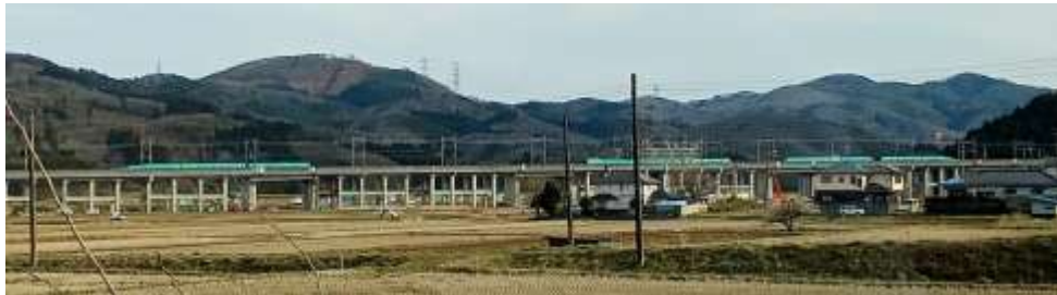
国道4号線から見た脱線現場
