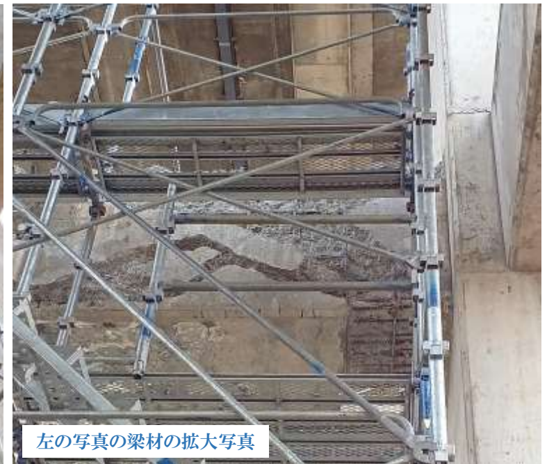
被害は3連ラーメン架構中間部の梁材に連続して発生しており、線路と直交方向に相当揺れたものと考えられる。
