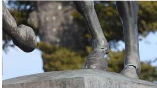
騎馬像基部の亀裂(3月17日付け河北新報)
