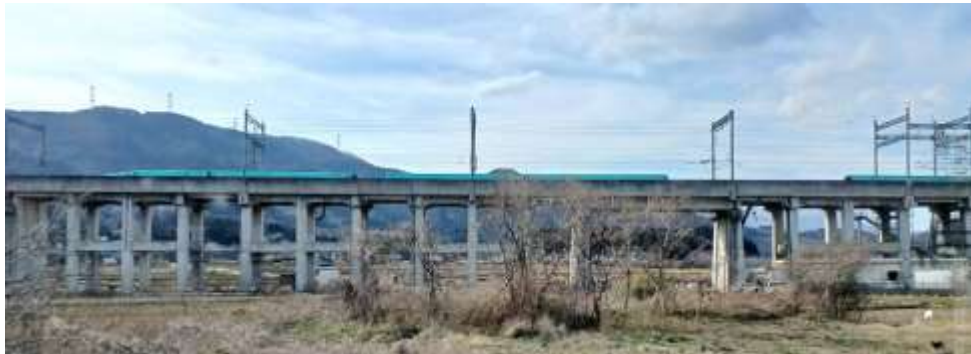
在来線の車中から見た脱線現場
