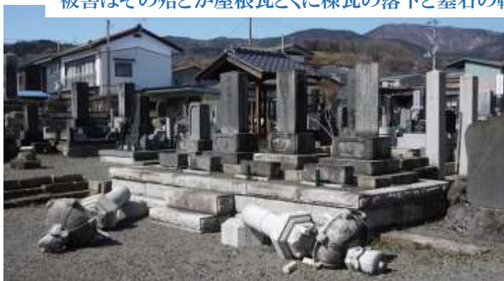
被害はその殆どが屋根瓦とくに棟瓦の落下と墓石の転倒のみ
