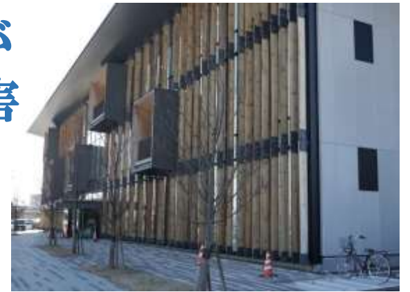
軟弱地盤に新設された国見町役場の庁舎
