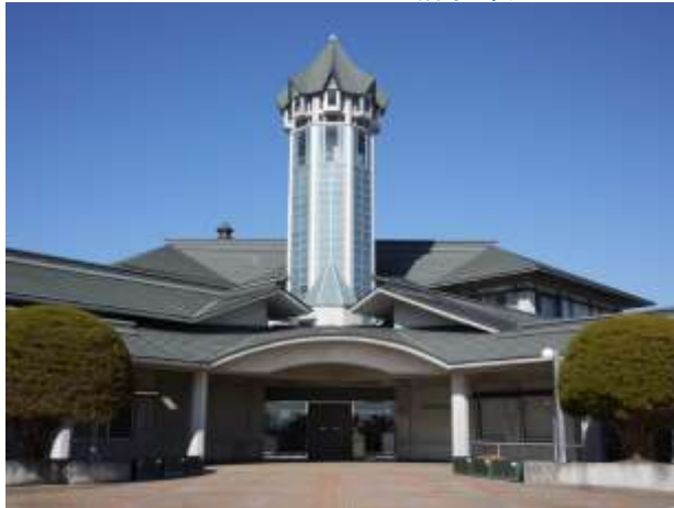
軽微な被害を生じた国見町文化センター
