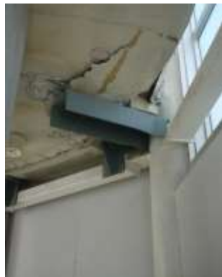
タワー階段床の剥離(鉄骨の補強は東日本大震災の時のもの)
