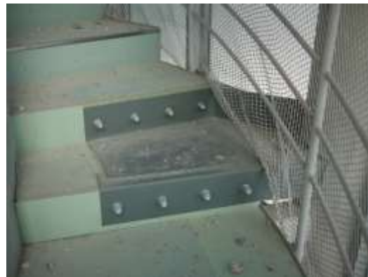
タワー階段床の剥離(鉄骨の補強は東日本大震災の時のもの)
