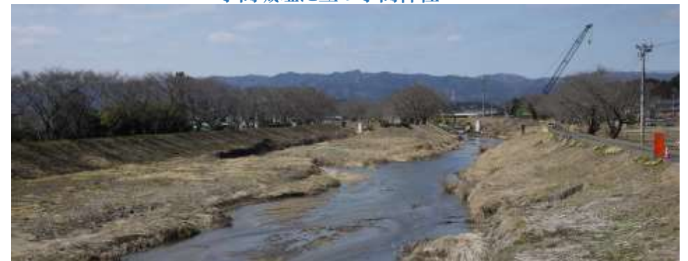
妙見橋から見た小高川上流側
