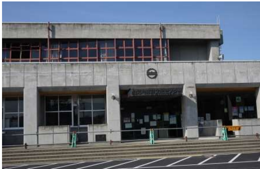
強震観測点が置かれた山元町立体育文化センター
