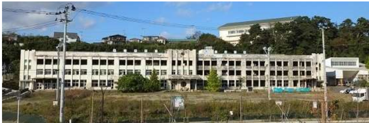
震災遺構が決定し改修工事に入る前の旧門脇小学校(2019年11月)
