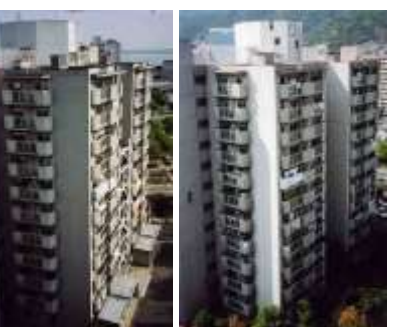
写真-10a,b 1981年の建築基準法改定の前後に建設された2棟の同型RCアパートには被害程度に著しい差異が認められた。左が耐震補強済みの旧基準の建物。(11)
