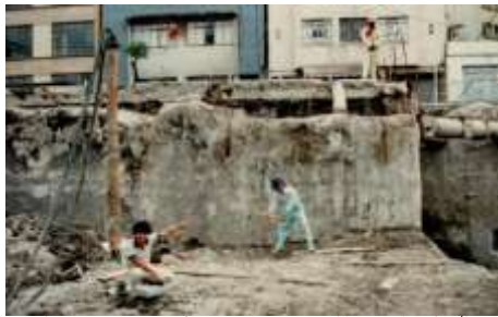
写真-4 地下鉄工事現場で行った小規模のS波調査(板たたき試験)。あまりにも軟弱地盤のため体感として振動を感じた。わが国では考えられないことである。
