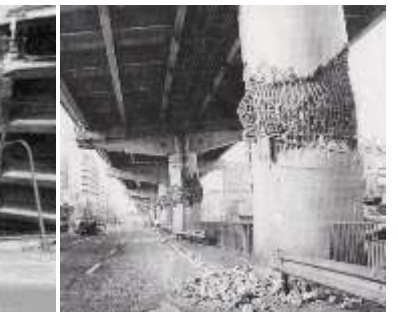
写真-7a~c 阪神高速3号神戸線の被害状況。工期短縮のためプレキャスト工法（ビルツ工法と呼ばれていた）を採用した区間（神戸市東灘区深江地区）が長さ600mにわたって北側に転倒した。転倒はきわめてゆっくり起こったようで、目撃証言によれば、トラックが倒壊に併せて斜面を滑り降りそのまま走り去ったとのことであった。他の区間では高速道路上からの落下を免れた高速バスが何日も放置されていた。(11)
