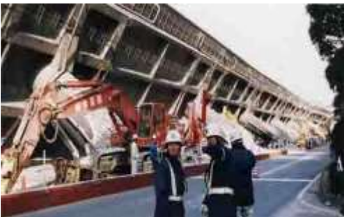
写真-7a~c 阪神高速3号神戸線の被害状況。工期短縮のためプレキャスト工法（ビルツ工法と呼ばれていた）を採用した区間（神戸市東灘区深江地区）が長さ600mにわたって北側に転倒した。転倒はきわめてゆっくり起こったようで、目撃証言によれば、トラックが倒壊に併せて斜面を滑り降りそのまま走り去ったとのことであった。他の区間では高速道路上からの落下を免れた高速バスが何日も放置されていた。(11)
