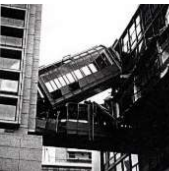
写真-11a~c 中間層が圧壊した神戸市役所2号館。高層建築の1号館との間の渡り廊下は全く圧縮を受けずに落下しているの、上層階は強烈かつ単純な水平動によって北側に崩壊したものと考えられる。この市役所2号館は震災遺構としてこのままの形で保存していただきたかったのであるが、しばらくしてから上層階は取り払われてしまった。誠に残念なことであった。(11)
