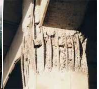
写真-6a~c JR新幹線高架橋の被害状況。新幹線の安全神話は脆くも崩れ去った。地震から4日後に被災地に向かい、阪西西宮北口駅から真っ先に新幹線の被災現場を訪れた。新大阪方面から六甲山トンネルに入る直前の地点で、橋脚の一部が地中に埋没し、直上の軌道は大きく陥没していた。地震が新幹線発着前に発生したため幸く電車の脱線転覆は免れることができた。(11)
