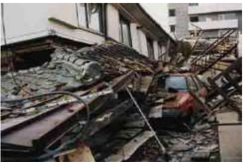
写真-8 西宮北口駅周辺の木造アパートの被害状況。このような木造建築の圧壊被害は『震災の帯』に沿って至る所で見られた。(11)
