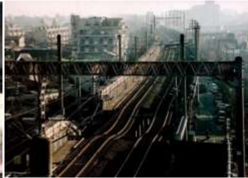
写真-6a~c JR新幹線高架橋の被害状況。新幹線の安全神話は脆くも崩れ去った。地震から4日後に被災地に向かい、阪西西宮北口駅から真っ先に新幹線の被災現場を訪れた。新大阪方面から六甲山トンネルに入る直前の地点で、橋脚の一部が地中に埋没し、直上の軌道は大きく陥没していた。地震が新幹線発着前に発生したため幸く電車の脱線転覆は免れることができた。(11)
