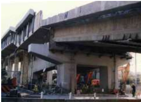
写真-6a~c JR新幹線高架橋の被害状況。新幹線の安全神話は脆くも崩れ去った。地震から4日後に被災地に向かい、阪西西宮北口駅から真っ先に新幹線の被災現場を訪れた。新大阪方面から六甲山トンネルに入る直前の地点で、橋脚の一部が地中に埋没し、直上の軌道は大きく陥没していた。地震が新幹線発着前に発生したため幸く電車の脱線転覆は免れることができた。(11)
