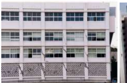
写真-9 神戸市東灘区岡本（阪急電車よりも山側）の甲南大学校舎の被害状況。強烈で単純な水平動の作用が見て取れる。(11)
