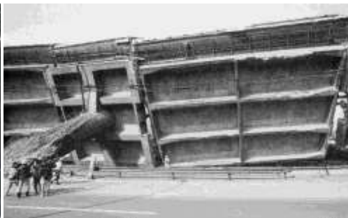
写真-7a~c 阪神高速3号神戸線の被害状況。工期短縮のためプレキャスト工法（ビルツ工法と呼ばれていた）を採用した区間（神戸市東灘区深江地区）が長さ600mにわたって北側に転倒した。転倒はきわめてゆっくり起こったようで、目撃証言によれば、トラックが倒壊に併せて斜面を滑り降りそのまま走り去ったとのことであった。他の区間では高速道路上からの落下を免れた高速バスが何日も放置されていた。(11)
