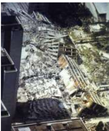
写真-1 被害が甚大なトラテロコ(TLATELOLCO)団地。15階建てRC造アパートは途中から折れて倒れた。左の写真は当時の写真週刊誌 Focus からの引用によるもので、3連のアパートのうちの2棟に注目している。右の写真は奥の1棟が倒壊を免れた様子を撮影したものである。3)
