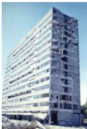
写真-1 被害が甚大なトラテロコ(TLATELOLCO)団地。15階建てRC造アパートは途中から折れて倒れた。左の写真は当時の写真週刊誌 Focus からの引用によるもので、3連のアパートのうちの2棟に注目している。右の写真は奥の1棟が倒壊を免れた様子を撮影したものである。3)
