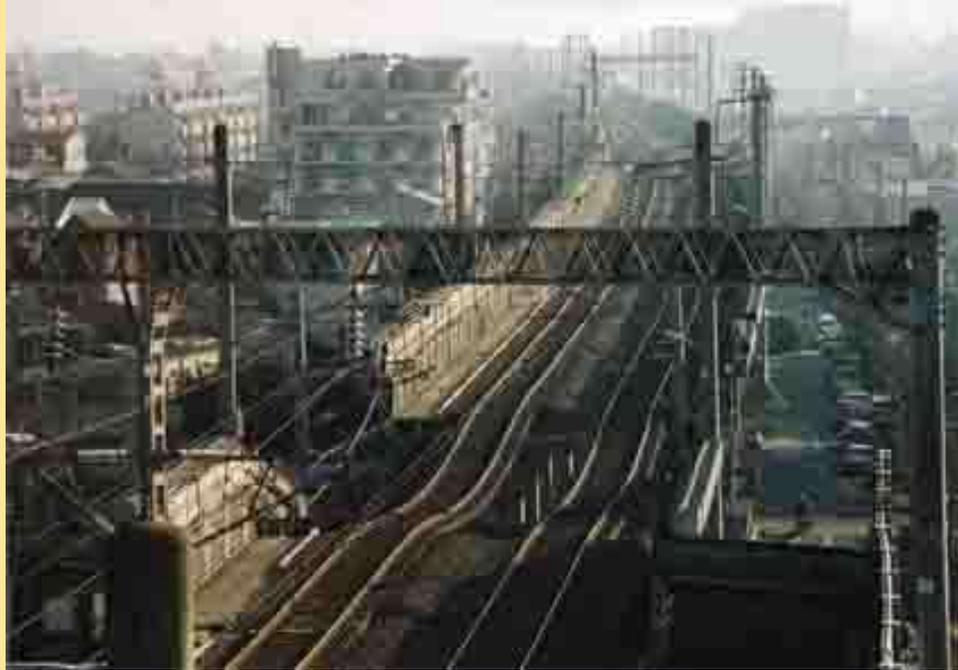
六甲山トンネル入口から撮影した新幹線軌道の陥没
