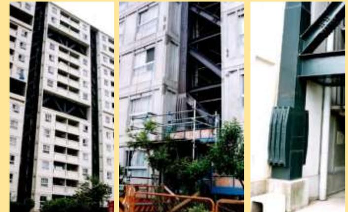
芦屋市芦屋浜高層住宅の鉄骨柱の破断
