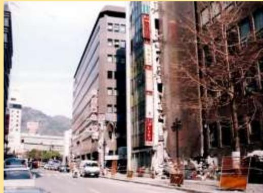
三宮ビルの間中層崩壊と1階圧壊
