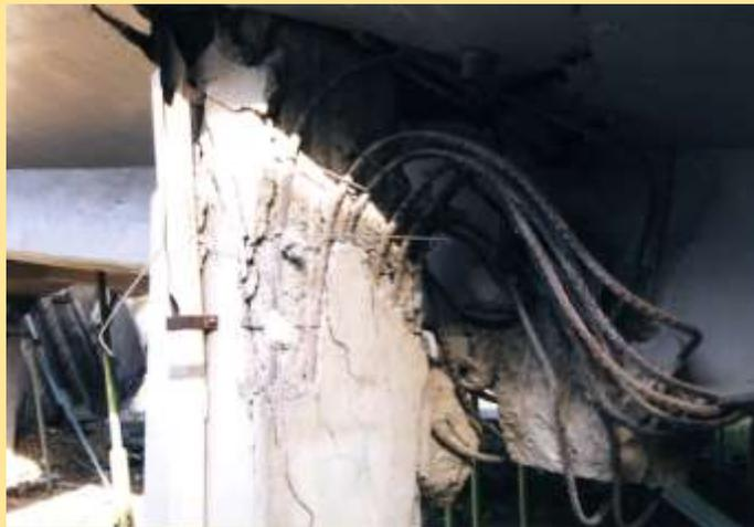
高架橋の柱はコンクリートの質が悪く帯筋が見られない。内側には木片も見える。
