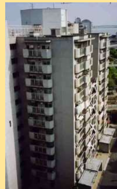
1981年の建築基準法改定の前後に建設された2棟の同型RCアパートには被害程度に著しい差異が認められた。左の写真が耐震補強済みの旧基準の建物(東灘区の県営青木団地)
