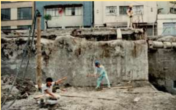
地下鉄工事現場の板たたき試験で有感
