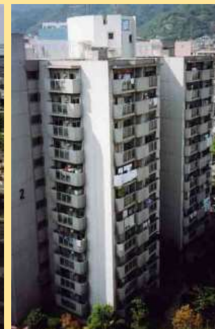
1981年の建築基準法改定の前後に建設された2棟の同型RCアパートには被害程度に著しい差異が認められた。左の写真が耐震補強済みの旧基準の建物(東灘区の県営青木団地)
