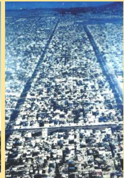
軟弱地盤上に広がる低層住宅群 長周期地震動との共振を免れて 無被害
