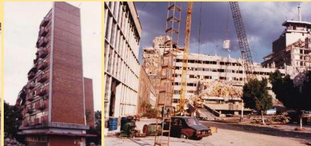
被害が大きかったメキシコシティ中心部. 右の写真は強震記録が得られたSCTの被害建物
